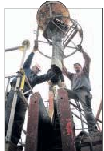
Für die Giebelwand dirigieren Betonbauer den Kübel mit 500 Liter Beton zur Schalung.
